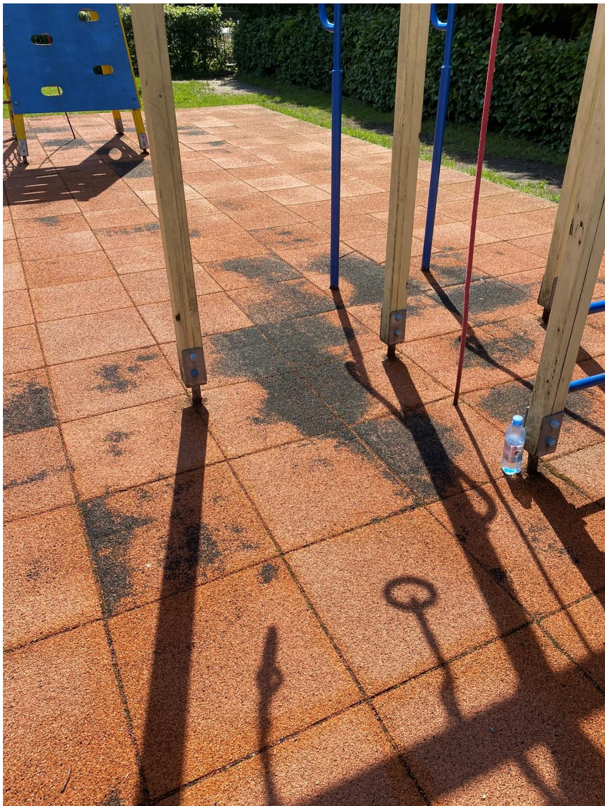
Zdj. 4- nawierzchnia i dolna część konstrukcji tworzącej plac zabaw.
