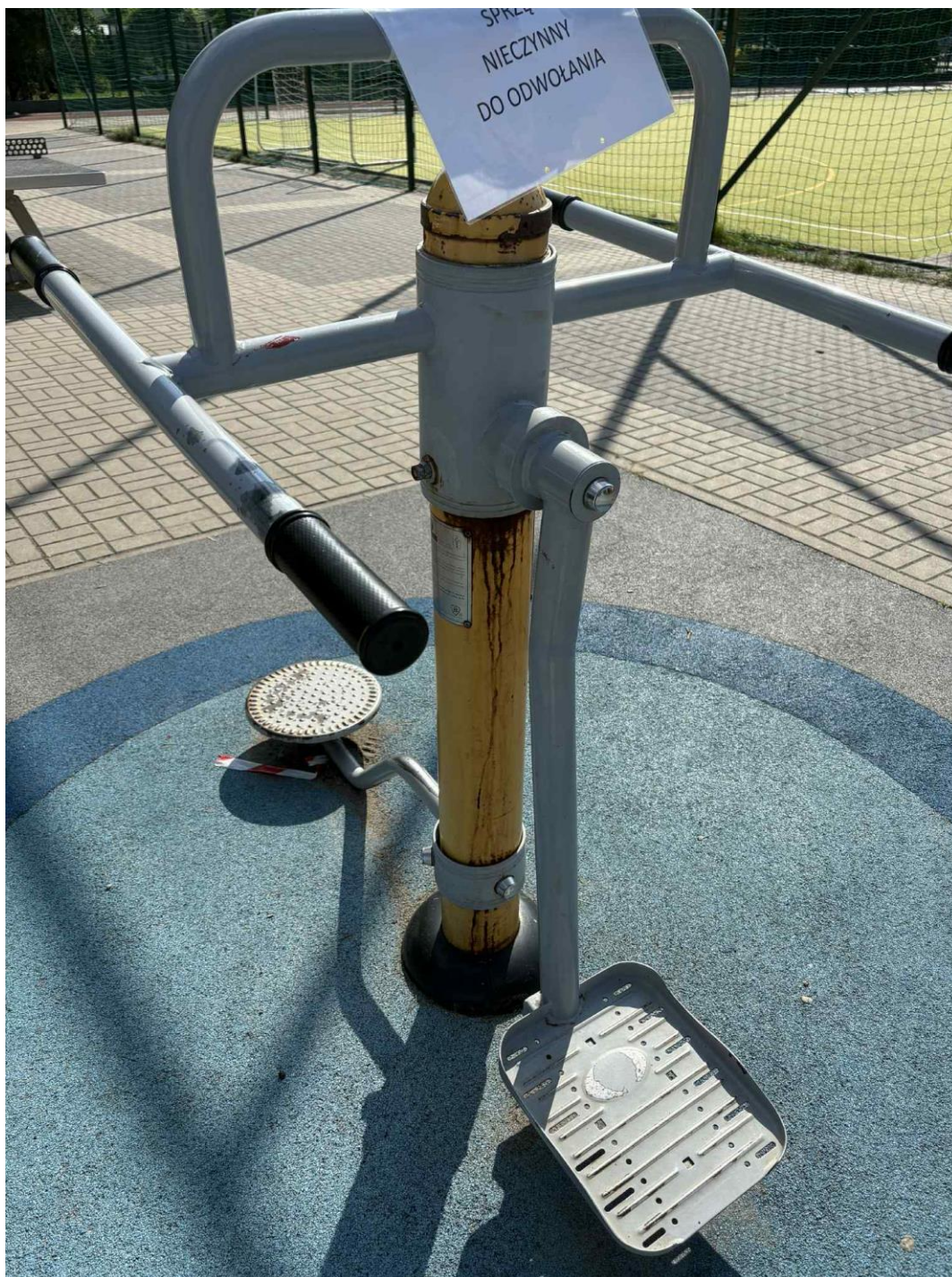
Zdj. 6 – jeden z elementów siłowni zewnętrznej wyłączony z użytkowania
